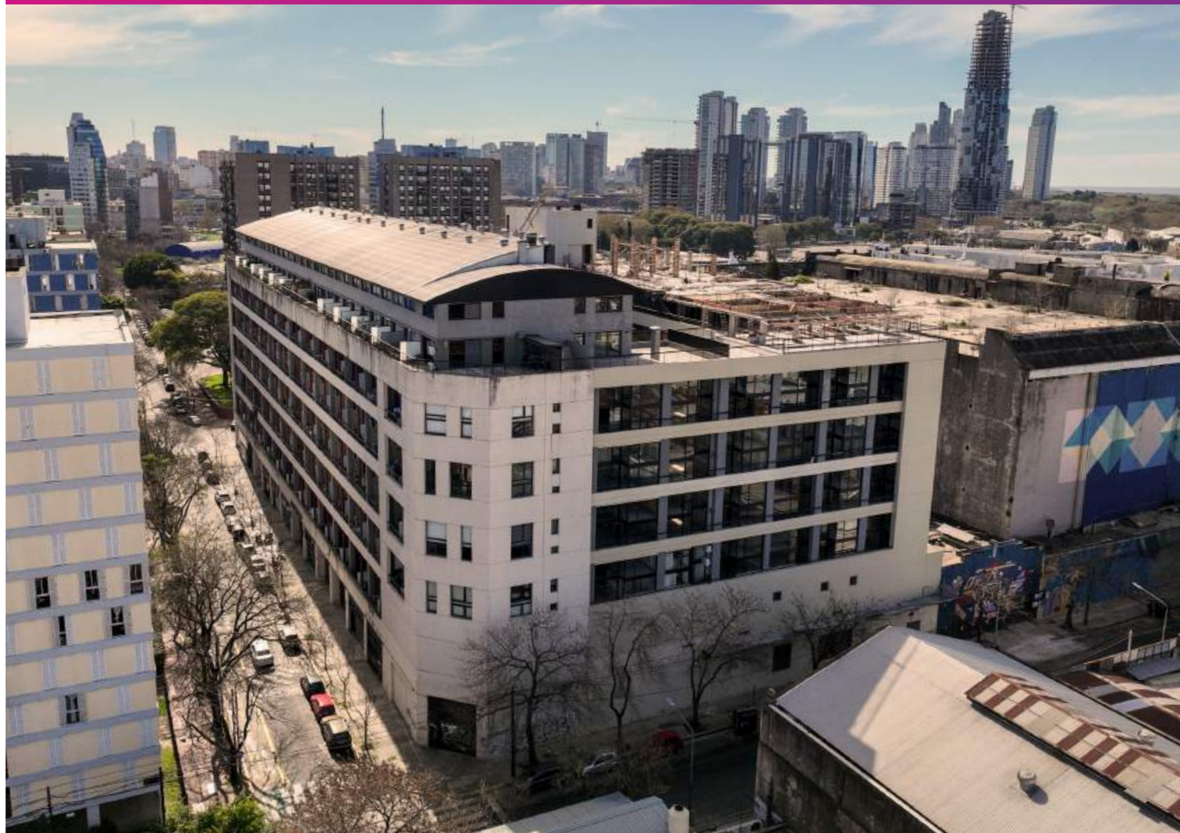
imagen aérea de los trabajos en etapa 2
