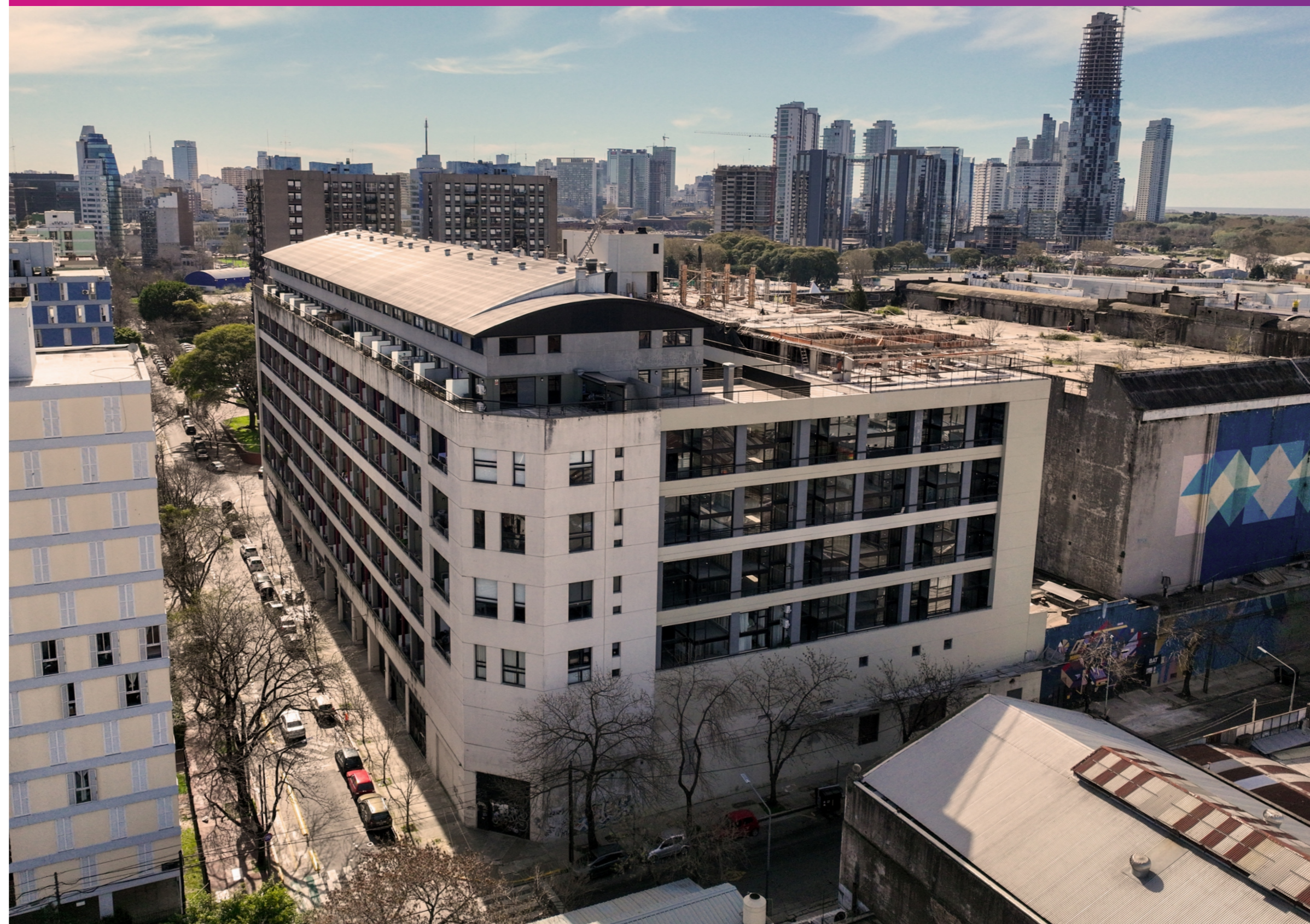
imagen aérea de los trabajos en etapa 2
