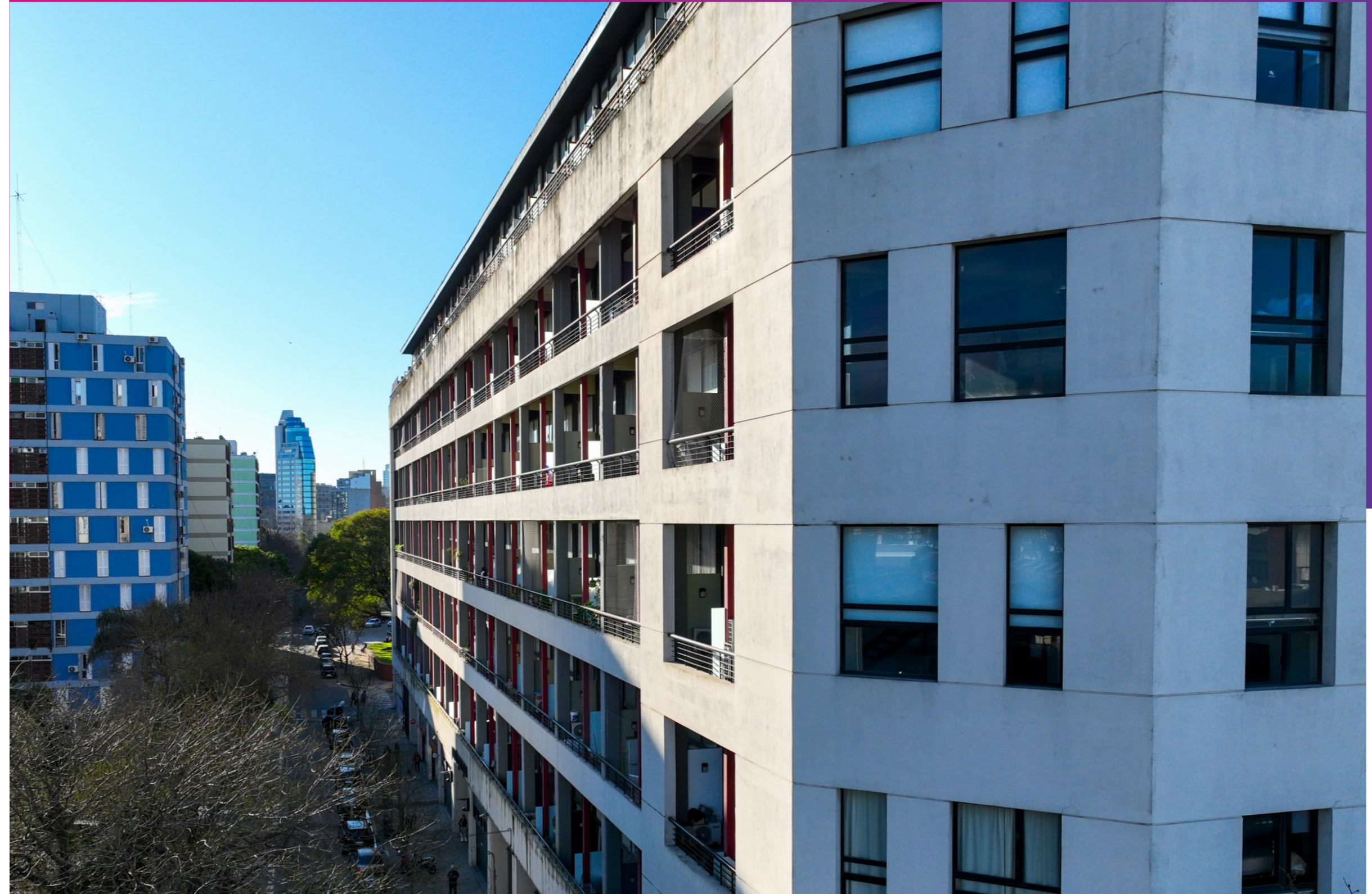
imagen aérea de la fachada Caboto
